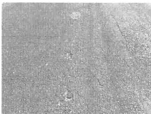
Foto 11 – Segregação da camada de asfalto -
