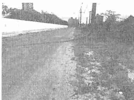
Foto 8 – Ausência de meio-fio e sarjeta - Trecho em frente ao antigo prédio da PF.
