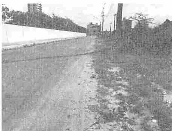
Foto 8 – Ausência de meio-fio e sarjeta - Trecho em frente ao antigo prédio da PF.
