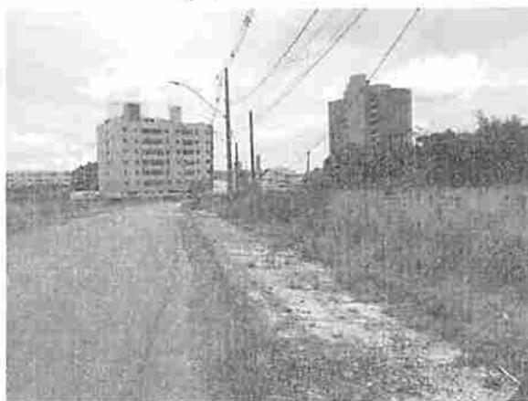
Foto 10 – Ausência de meio-fio e sarjeta - Trecho próximo ao antigo prédio da PF.
